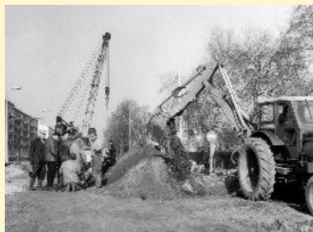
Gāzesvada ierīkošana Klaipēdas ielā Liepājā. 1972. gada 20. janvāris.
