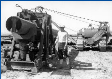
Gāzes cauruļu izkraušana. Caurules izgatavoja Urālu metalurgi gāzesvada Dašava-Minska-Viļņa-Rīga celtniecībai. Maģistrāles būve pāvērsies uz Rīgu. Lietuva, 1961. gada 9. jūnijs.
