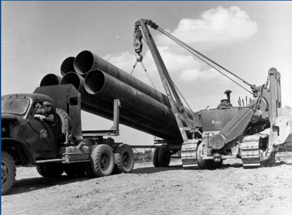
Gāzes cauruļu izkraušana. Caurules izgatavoja Urālu metalurgi gāzesvada Dašava-Minska-Viļņa-Rīga celtniecībai. Maģistrāles būve pāvērsies uz Rīgu. Lietuva, 1961. gada 9. jūnijs.
