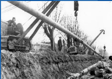
Gāzesvada būvniecība Dašavas gāzes saņemšanai. Rīga, 1962. gada 13. aprīlis.
