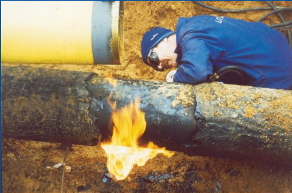
Vecās gāzes regulēšanas stacijas tehnoloģiskās līnijas nogriešana no pienākošā maģistrālā gāzesvada.
