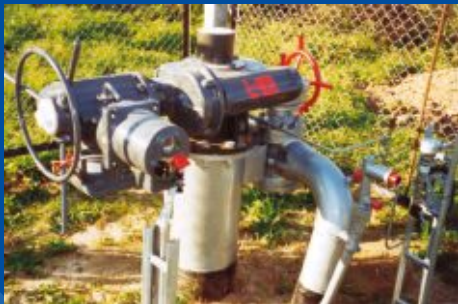
Modernizētie krāni ir atverami un aizverami no dispečeru pults.
